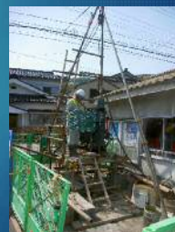
現場例（掘削中）
