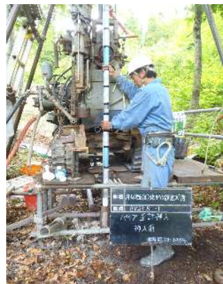
パイプ歪計設置状
