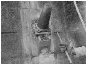
支圧板の打音点検
