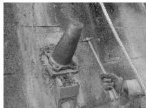
頭部キャップ、固定ボルトの打音点検
