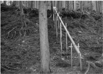
写真14 保護管設置
