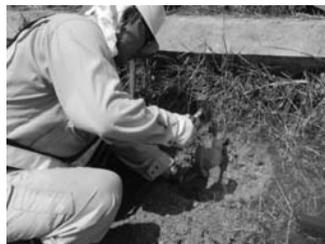
写真7 取付金具打込み
