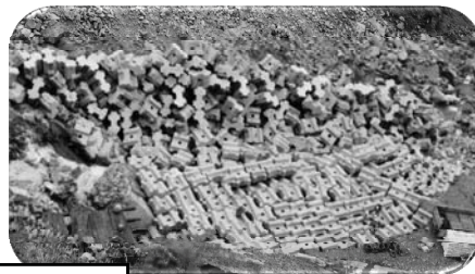
H16の中越地震では、 コンクリートブロックの 利用が多かった →ページ参照
