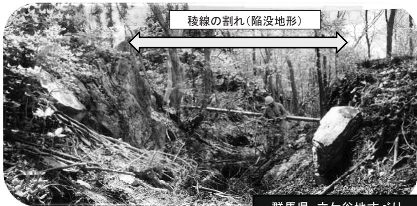
群馬県: 立ヶ谷地すべり
