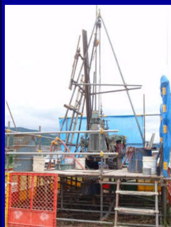
ボーリング作業例
