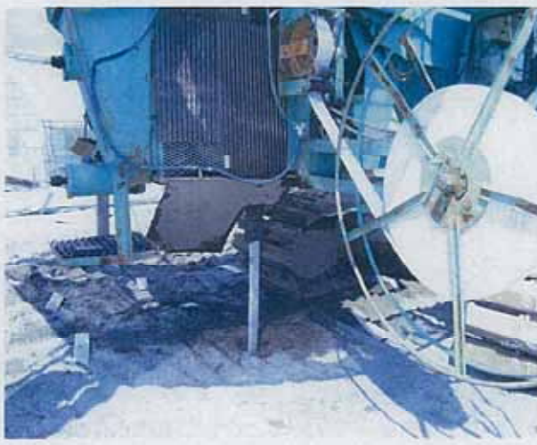
5. ケーシング引き抜き
