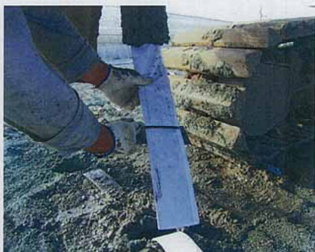
1. アンカープレート取付け
