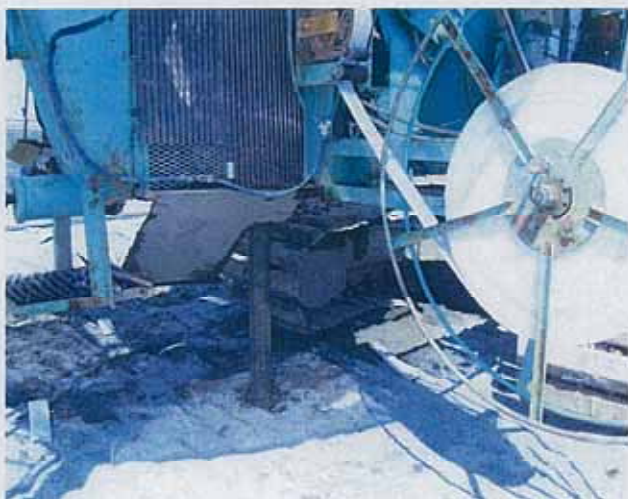
4. ドレーン打込み
