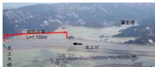
東日本大震災における河川・海岸施設の被害及び復旧状況 平成23年7月11日現在, 東北地方整備局河川部資料より引用
