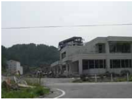
防潮堤の倒壊・流出
