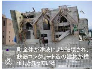
② 町全体が津波により破壊され、鉄筋コンクリート造の建物が横倒しとなっている
