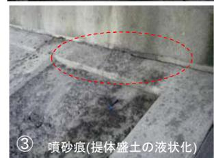
本視察箇所の淵尻上流地区(江合川左岸27.4k+60m~27.8k)は、基礎地盤の液状化と閉封飽和域の液状化の複合パターンである。
